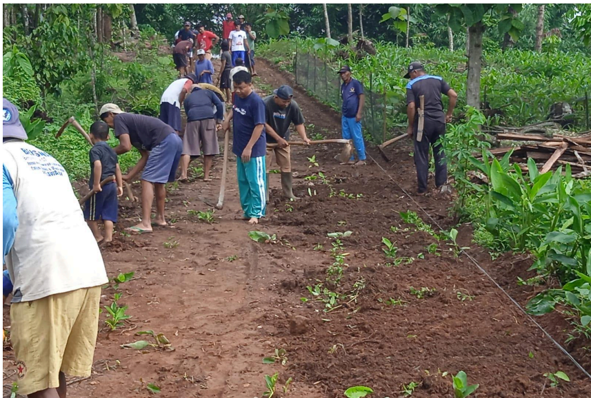
Gambar 5 : Gotong Royong Warga Desa Purworejo pembukaan jalan baru
